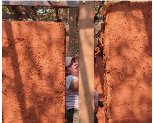
Die Zusammensetzung der einzelnen Putzschichten besteht wieder zu verschiedenen Teilen aus Erde, Wasser und Reishülsen, wobei der Anteil der Hülsen und die Stärke der jeweiligen Putzschichten mit jeder neuen Schicht sukzessive abnimmt. Die finale Schicht schließlich kommt gänzlich ohne Reishülsen aus, stattdessen werden feiner Sand und zuvor aufgekochte Tapiokastärke beigemischt.
