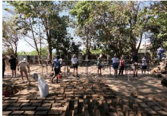
den Teilnehmenden und Arbeitern sorgfältig mit Macheten angespitzt wurden, fixiert. Um dem seitlichen Druck des Betons standzuhalten, wurden zusätzliche Querstreben aus Eukalyptus angebracht. Diese stabilisierten die Schalung und verhinderten ein Verformen während des Betonierens. Mithilfe einer Schlauchwaage, in die Wasser gefüllt wurde, wird die Schalung auf ein einheitliches Niveau gebracht und justiert, um ein waagerechtes Fundament zu gewährleisten.
