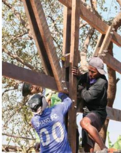
nachträglich abgelängt, da aufgrund der ungleichmäßigen Holzqualität kein exakter Zuschnitt im Voraus möglich war. Das Aufrichten der Tragstruktur erfolgte in zwei Phasen. Zunächst wurden die Träger in zwei Hälften unterteilt und getrennt montiert. Die hintere Reihe wurde mit etwa 15 Personen in Position getragen, auf die Stützenfüße gesetzt, ausgerichtet und verschraubt. Im zweiten Schritt folgte der vordere Teil der Träger.
