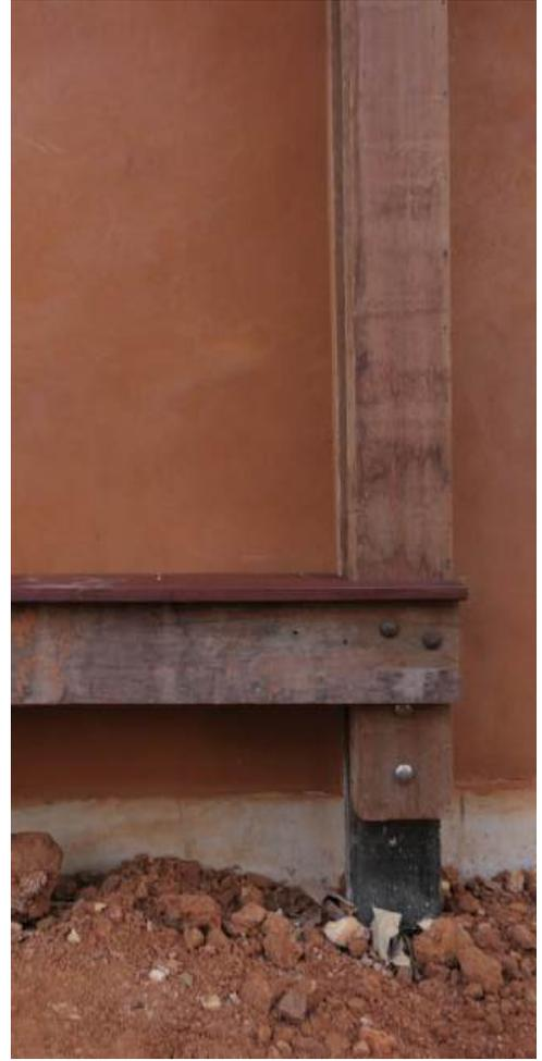
die eine vollständige Schließung der Öffnung ermöglicht. Zwei massive Holzläden laufen auf Rollen in einer oberen und unteren Holzschiene, die nahtlos in die Tragstruktur aus Stützen und Trägern integriert wurde.
