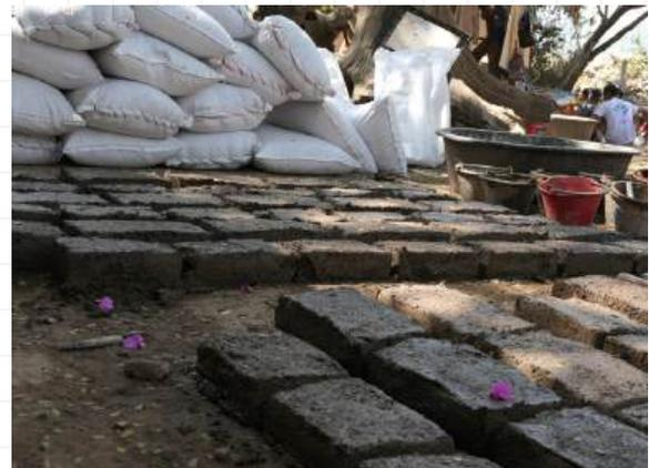
Bildung von Klumpen oder Nestern zu vermeiden. Sobald eine homogene Mischung entstanden ist, wird der Baulehm in angefeuchtete Formrahmen gefüllt. Die verwendeten Formen haben in diesem Projekt die Maße 40 × 20 × 10 cm sowie 30 × 20 × 10 cm. Durch die Befeuchtung der Rahmen wird sichergestellt, dass sich der Lehm später leichter entformen lässt.
