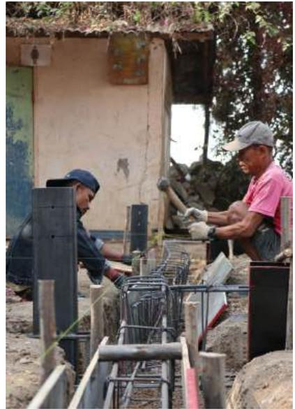
mit kleinen Steinen unterlegt, um eine gleichmäßige Betonüberdeckung von etwa 2,5 cm sicherzustellen. Diese Schicht schützt die Bewehrung vor Feuchtigkeit und Rost und verleiht den Fundamenten die notwendige Stabilität und Langlebigkeit.
