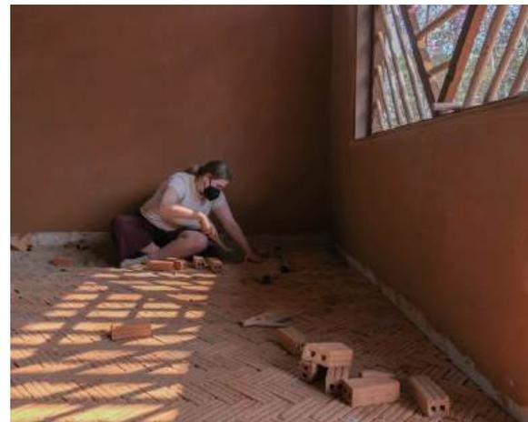
Verlegung wurde der Boden erneut mit Sand verfüllt und verdichtet, um eine stabile und gleichmäßige Grundlage zu schaffen. Dies war entscheidend, um sicherzustellen, dass der Bodenbelag dauerhaft belastbar und widerstandsfähig bleibt. Zur Verdichtung der Fugen wurden Gummihammer, Kellen und Besen verwendet.
